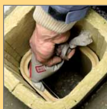
11. Накласти кислотостійку замазку.
