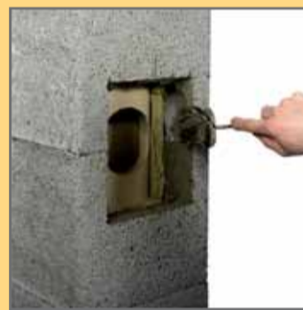
17. На стінки підготованого отвору накласти розчин.
