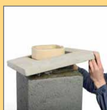
26. Встановити на розчин бетонну накривну плиту.
