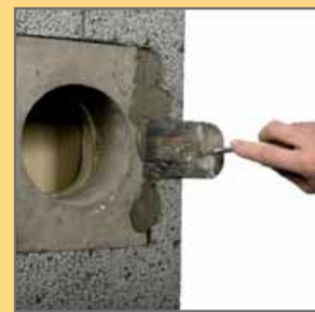
18. ... і поставити на нього бетонний приєднувальний елемент.
