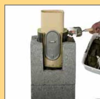
6. Накласти будівельний розчин на пустотілий блок.
