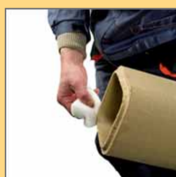
10. Очистити шпунтове з'єднання волокна вологою губкою.
