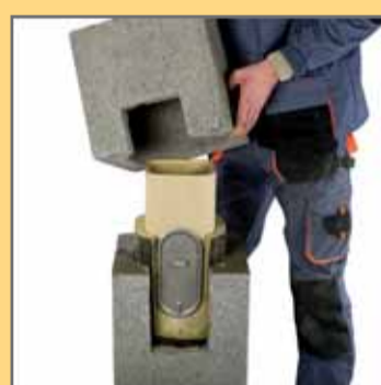
7. Пустотілий блок з наступною частиною вирізу розмістити на розчині.
