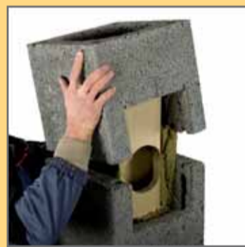
16. Розмістити пустотілий блок на розчині з наступною частиною вирізу.
