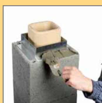
25. Встановити незнімну опалубку, накласти будівельний розчин.
