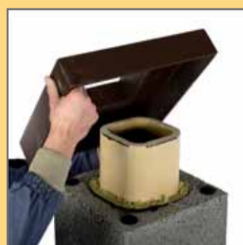
22. Покласти накривну цементно-волоконну плиту.
