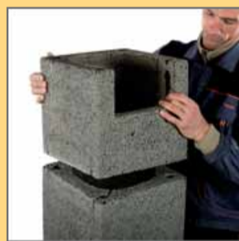
13. Пустотілий блок з вирізаним отвором на коліно димових газів поставити на розчин.
