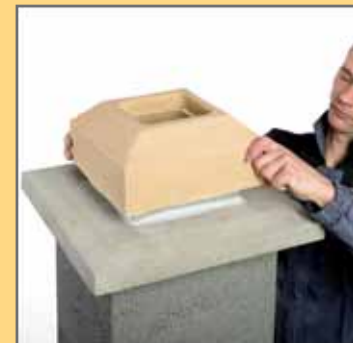
30. Приклеїти керамічну обшивку гирла димоходу.
