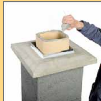
29. Накласти замазку на підрізану керамічну трубу.
