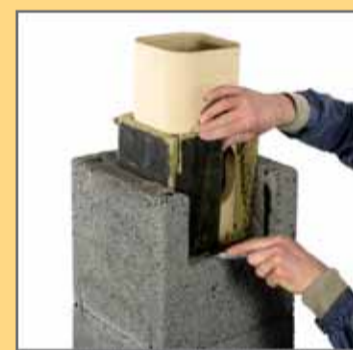
15. Підрізати волокно до підготованого отвору.
