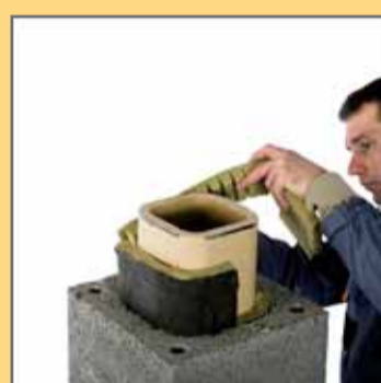
19. Відрізати надмір волокна за останнім пустотілим блоком.
