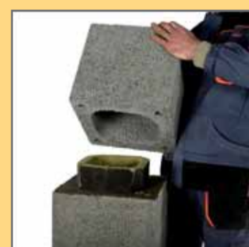
9. Розмістити на розчині наступний пустотілий блок.
