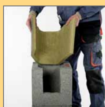
2. Поставити пустотілий блок з вирізаним отвором на дверцята (16x31 см) на цоколі, встановити плиту з мінерального волокна.
