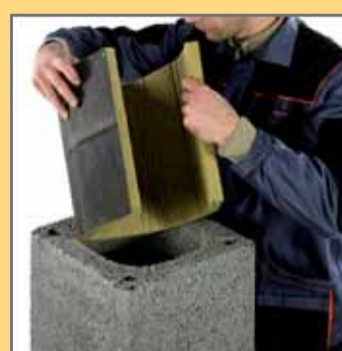
8. Вкласти мінеральне волокно до наступного пустотілого блоку.
