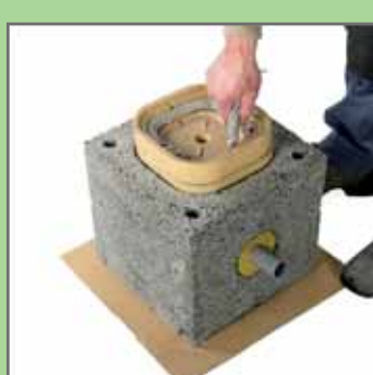
5. Накласти кислотостійку замазку на ємність для відведення конденсату.
