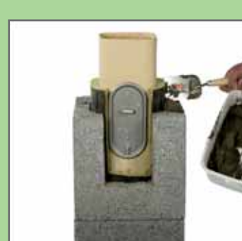
12. Накласти будівельний розчин на пустотілий блок.
