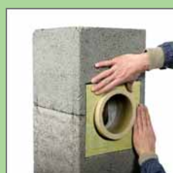
24. У вирізаний пустотілий блок вставити плитку з мінерального волокна.
