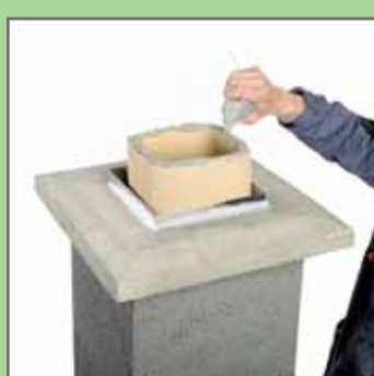
35. Накласти замазку на підрізану керамічну трубу.
