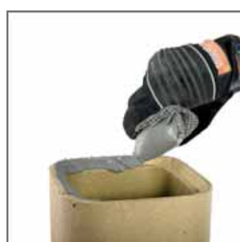
7. Нанести замазку на шпунтове з'єднання.
