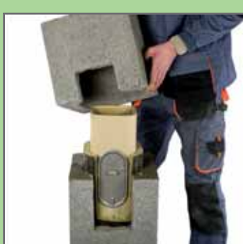
13. Пустотілий блок з наступною частиною вирізаного отвору посадити на розчин.
