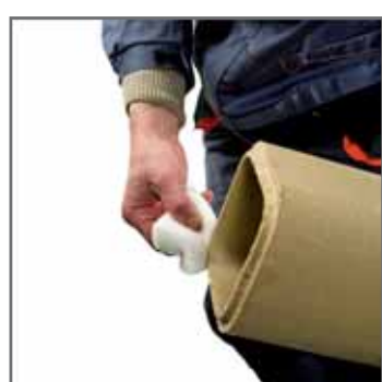
6. Вологою губкою очистити шпунтове з'єднання на кераміці.
