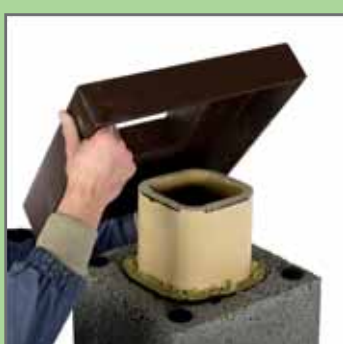
28. Покласти накривну цементно-волоконну плиту.
