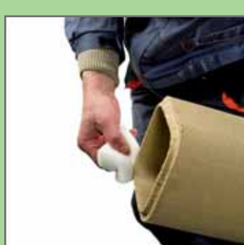
8. Очистити шпунтове з'єднання вологою губкою.
