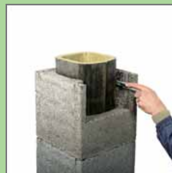
21. Підрізати волокно до підготованого отвору.
