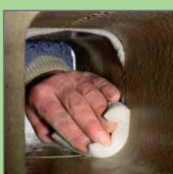
17. Усунути надлишок замазки з внутрішньої сторони шва за допомогою вологої губки.
