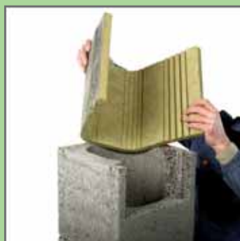
20. Розмістити плиту з мінерального волокна.
