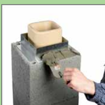
31. Встановити незнімну опалубку, накласти будівельний розчин.
