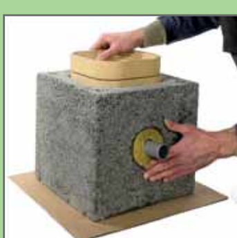
4. З'єднати ємність для відведення конденсату і цокольную трубу.
