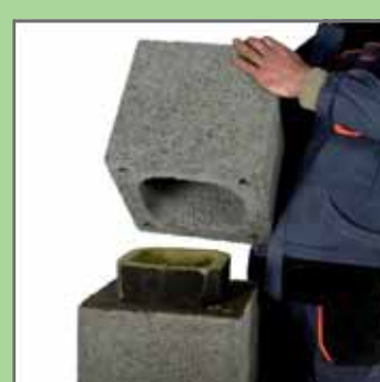
15. Розмістити на розчині наступний пустотілий блок.
