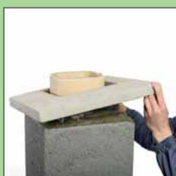
32. Встановити на розчин бетонну накривну плиту.
