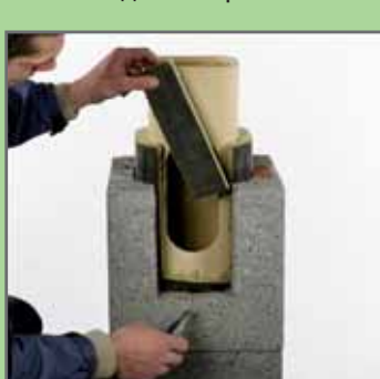
10. Підрізати плиту з мінерального волокна до розмірів отвору в пустотілому блоці.
