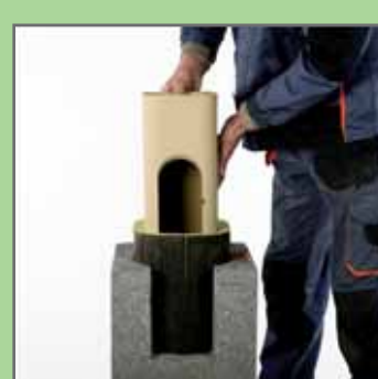
9. Встановити ревізійний отвір у ємність для відводу конденсату, усунути надлишок замазки з внутрішнього боку труби.
