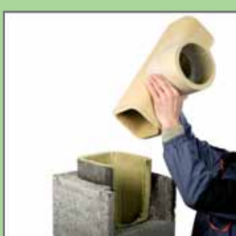
22. Приклеїти трійник (під'єднання печі).
