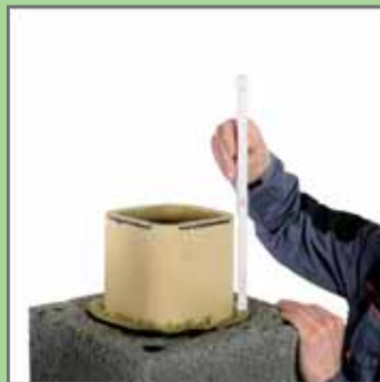
26. Відміряти потрібну довжину керамічної труби так, щоб керамічне облицювання гирла димоходу було на 1 см вище накривної плити.
