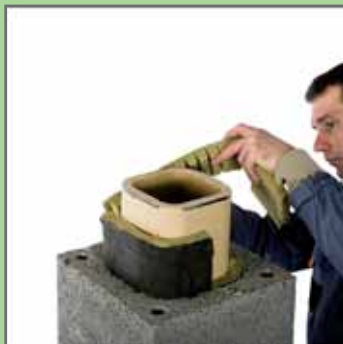
25. Відрізати надмір волокна за останнім пустотілим блоком.
