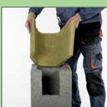
7. Розмістити плиту з мінерального волокна.
