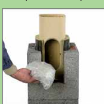
11. В середину очисного люка покласти шматок фольги або листок паперу, щоб захистити від падаючого будівельного розчину.
