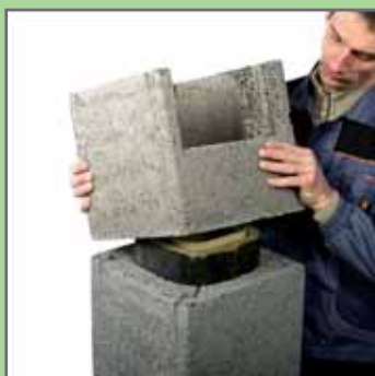
19. Пустотілий блок з вирізаним отвором для коліна продуктів згоряння посадити на розчин.
