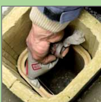
16. Накласти кислотостійку замазку.
