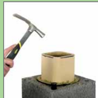
27. Вбити монтажні кілочки в наріжні отвори пустотілого блока.
