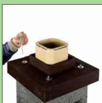
29. Закрутити гвинти, накласти гумові і металеві шайби, прикрутити ковпачковими гайками.
