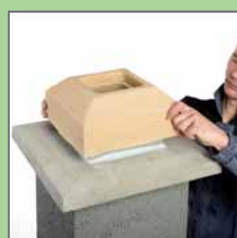
36. Приклеїти керамічну обшивку гирла димоходу.
