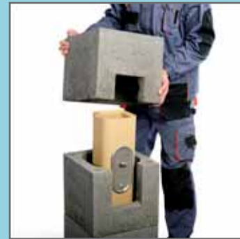
9. Пустотілий блок з наступною частиною вирізу встановити на розчині.
