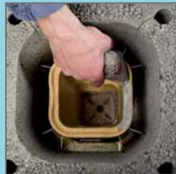
11. Накласти кислотостійку замазку.
