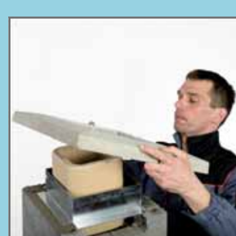
30. Накласти бетонну накривну плиту.
