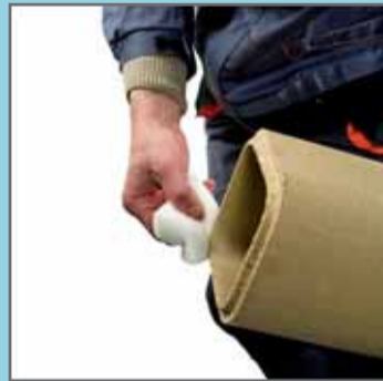
7. Очистити шпунтове з'єднання вологою губкою.
