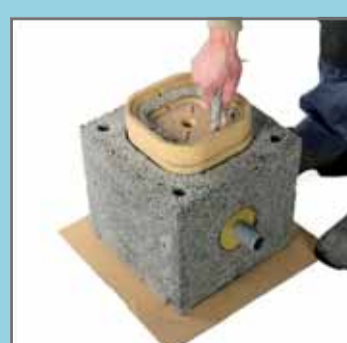
5. Накласти кислотостійку замазку на тарілку відведення конденсату.
