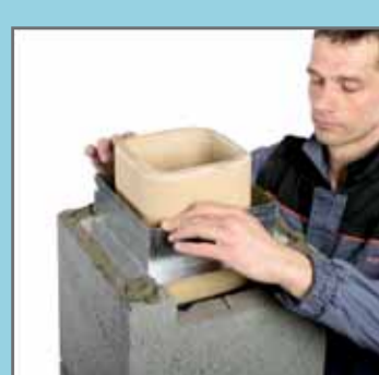
29. Встановити незмінну опалубку на розчині.
