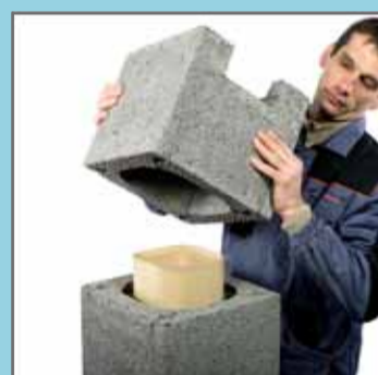
20. Пустотілий блок з вирізаним отвором на під'єднання димохідних газів встановити на розчині.
