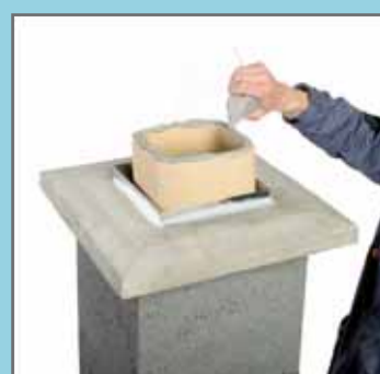
32. Накласти замазку на підрізану керамічну трубу.
