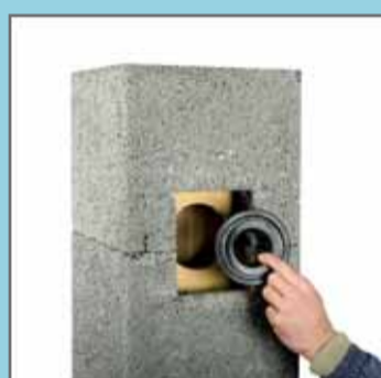
22. Встановити приєднувальні прокладки LAS в кераміці.
