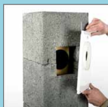
23. Відцентрувати панель з під'єднанням в кераміці.
