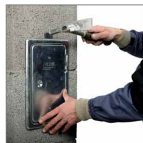
Зовнішні дверцята прочистки кріпляться за допомогою цвяхів (покрівельних цвяхів).
