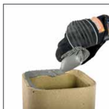
7. Нанести замазку на шпунтове з'єднання.
