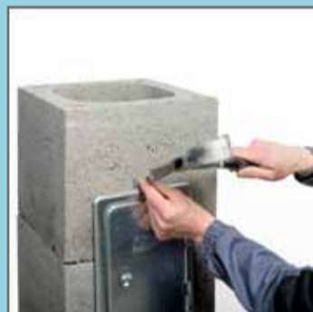
13. Прикріпити зовнішні дверцята ревізійного отвору цвяхами (будівельними цвяхами).
