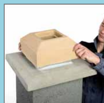
33. Приклеїти керамічну заслону виходу димоходу.
