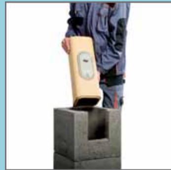
8. Встановити ревізійний отвір у диск відведення конденсату, усунути надмір замазки з внутрішнього боку труби.
