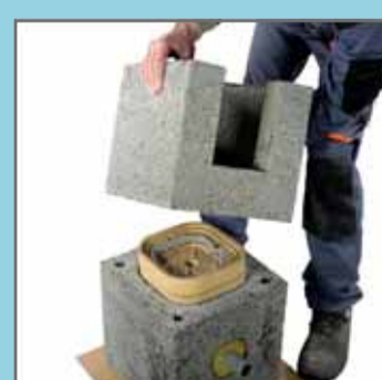
6. Встановити пустотілий блок з вирізаним отвором на дверцята (16x31 см).
