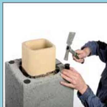
25. Відміряти потрібну довжину керамічної труби (приблизно 16 см) від останнього пустотілого блоку. При потребі зменшити трубу використовуючи кутову шліфувальну машину. Вбити закріпи у наріжні отвори пустотілого отвору.
