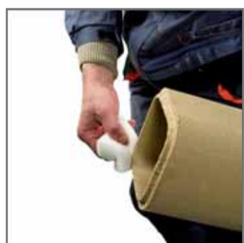
6. Перед накладанням замазки вологою губкою очистити шпунтове з'єднання.
